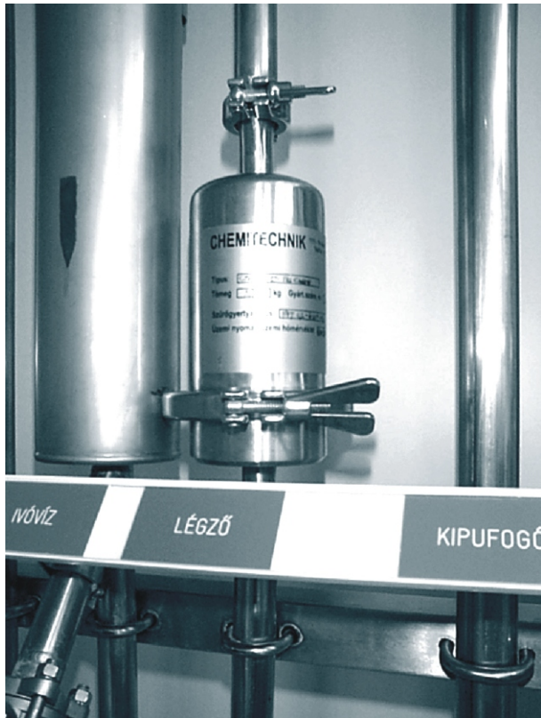
CTK-FI T0425 Légzővezetékbe építhető szűrő
